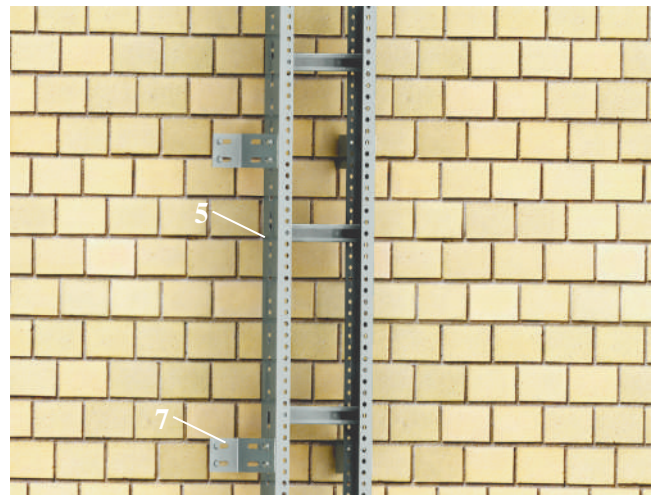
Монтаж на уголках регулируемых к стене вертикально
